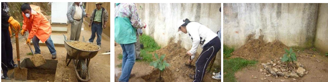
Figure 43: Vaciado de una Fosa Alterna y plantación de árbol de aguacate.
