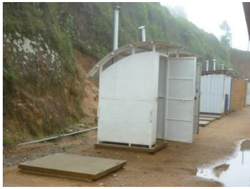
Figure 42: Casetas de fosa Alterna construidas en la Primaria Hidalgo.
