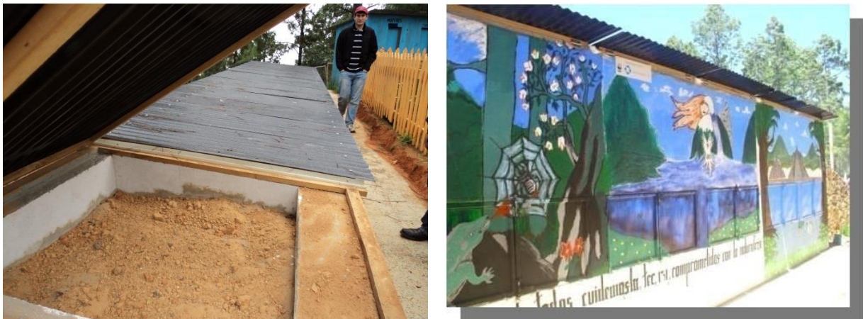
Figure 38: Popostero Secundaria Técnica 131, San Miguel Suchixtepec. área superior y parte trasera por donde se vacían las heces una vez reposadas
